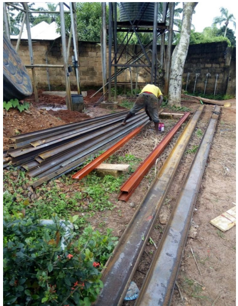
Stahlträger für die neue Plattform
