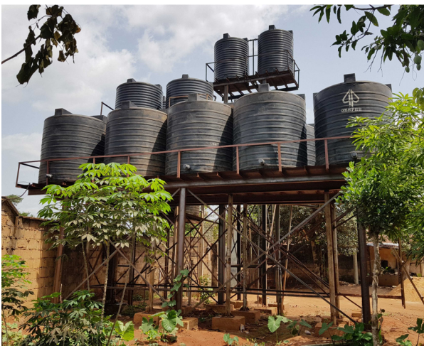
Die fertige Anlage
