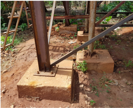
Fundamente der Plattform
