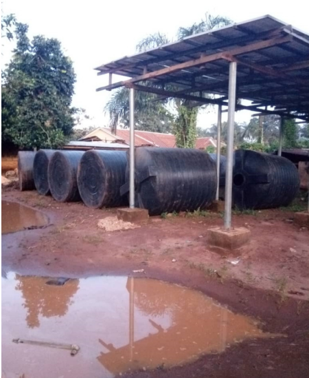
Wassertanks sind angeliefert
